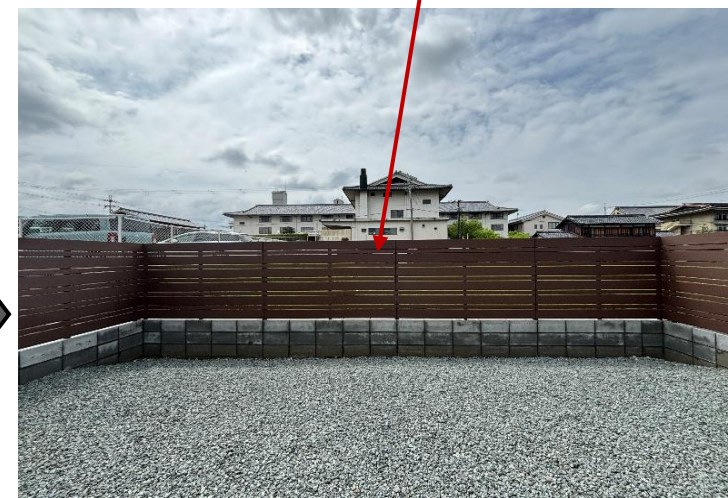
エコモックフェンス設置
