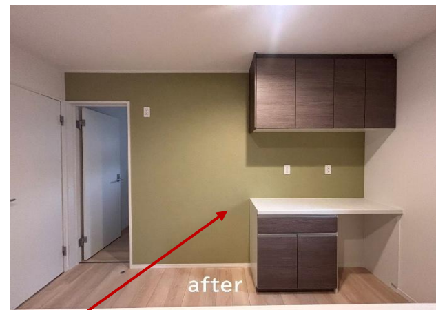
クロス張替+コンセント増設+カップボード設置
