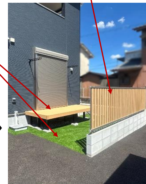
塀+フェンス設置
